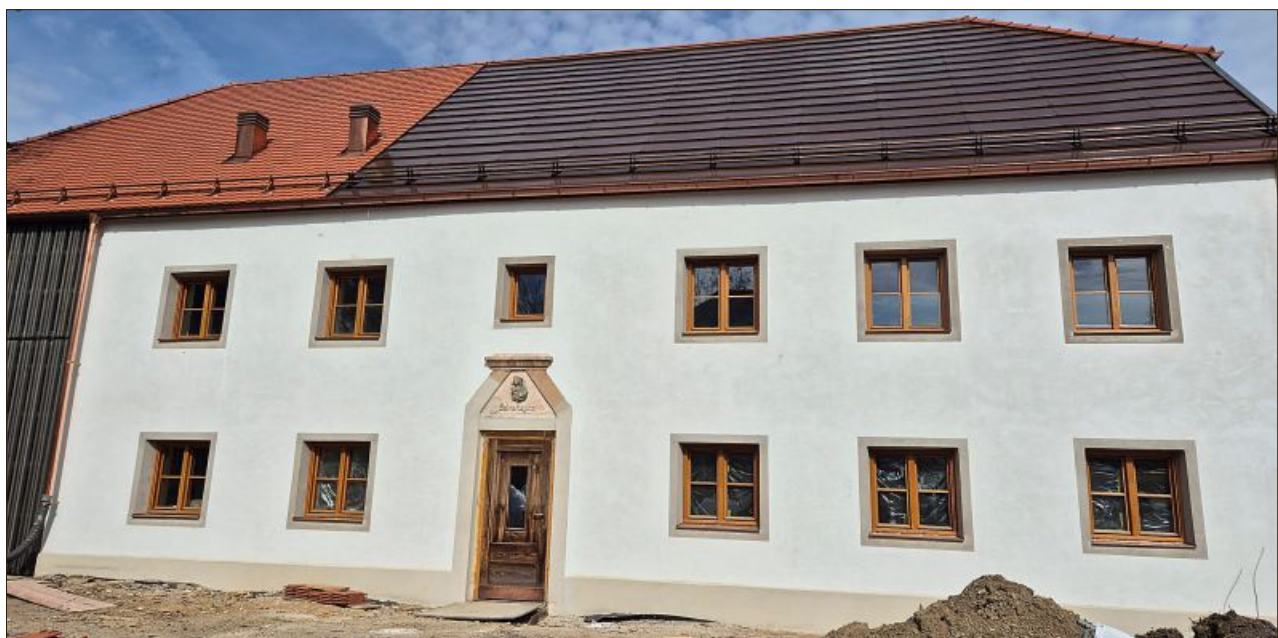
Anschauungsobjekt für eine ökologische Sanierung unter Denkmalschutzaufgaben: das Gärtnerhaus mit der PV-Anlage auf dem Dach und neuen Eichenfenstern nach historischem Vorbild.
