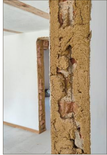
Mit Lehm wurden auch die Wände verputzt, wie hier an der Türleibung gut zu erkennen ist.
